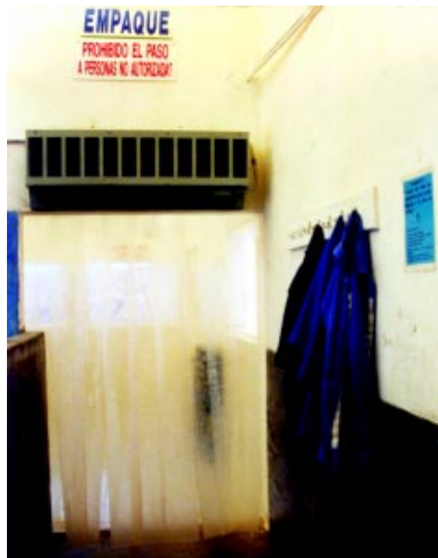
Figura 4.8 Entrada al área de empaque en una planta procesadora de productos acuícolas separada mediante una cortina sanitaria del resto del proceso.
